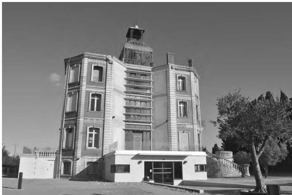
Figura 8. Vista desde la entrada del edificio tras su rehabilitación. Colección particular (15 de febrero de 2013).
